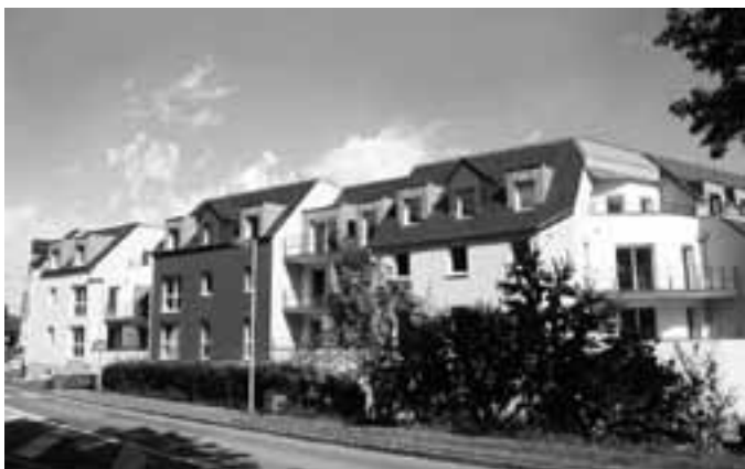
Façade ouest de la résidence
